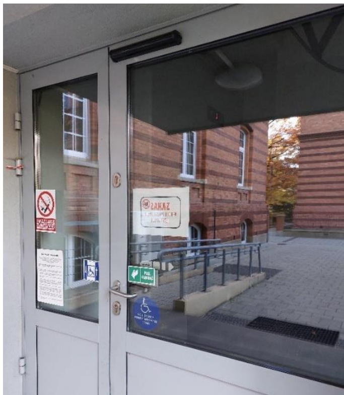
Zdjęcie 11. Wejście do windy do budynku WIŚiE
