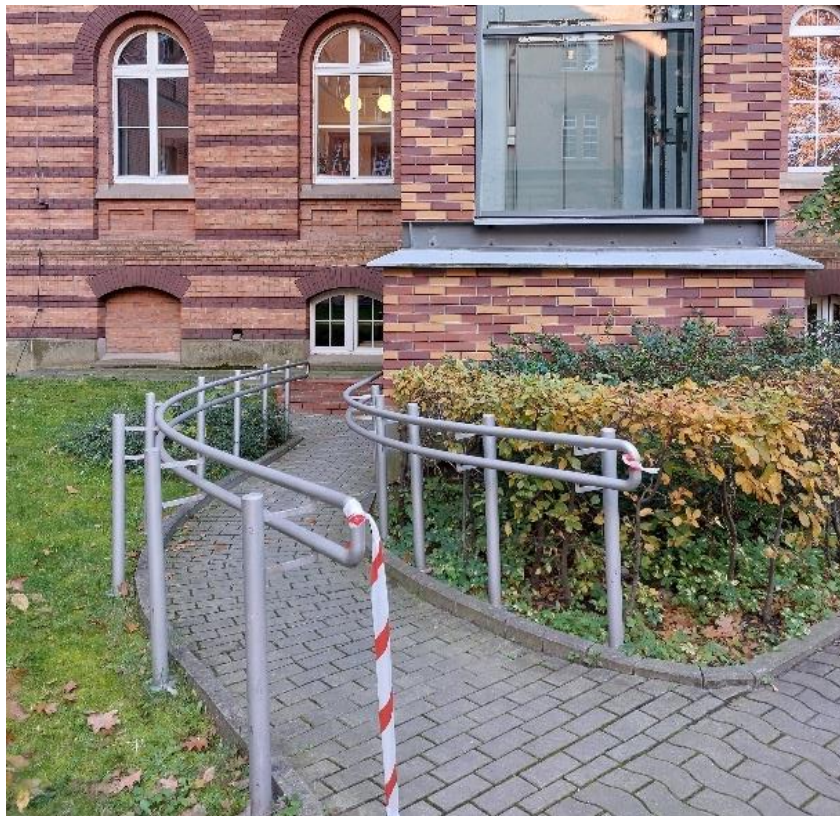
Zdjęcie 7. Podjazd do windy w budynku WIL
