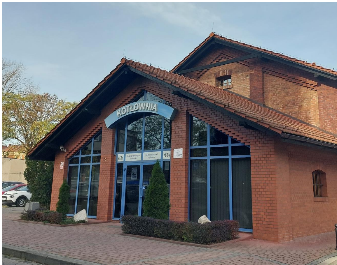
Zdjęcie 21. Budynek konferencyjny „Kotłownia”
