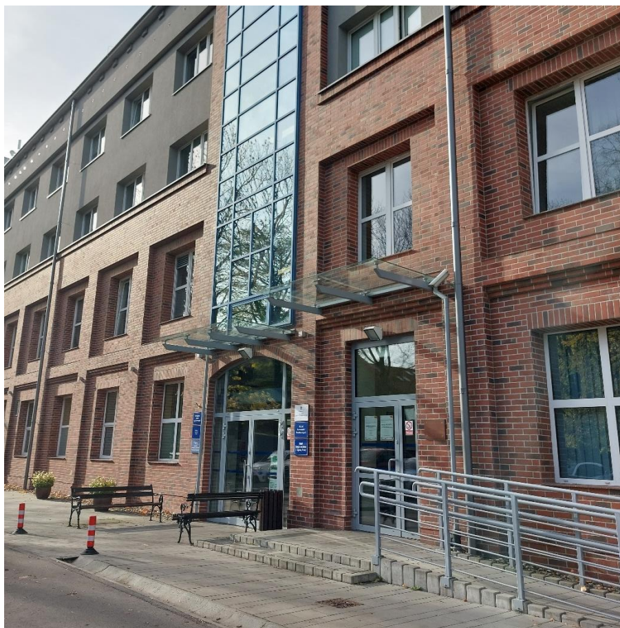
Zdjęcie 18. Wejście do budynku CUP
