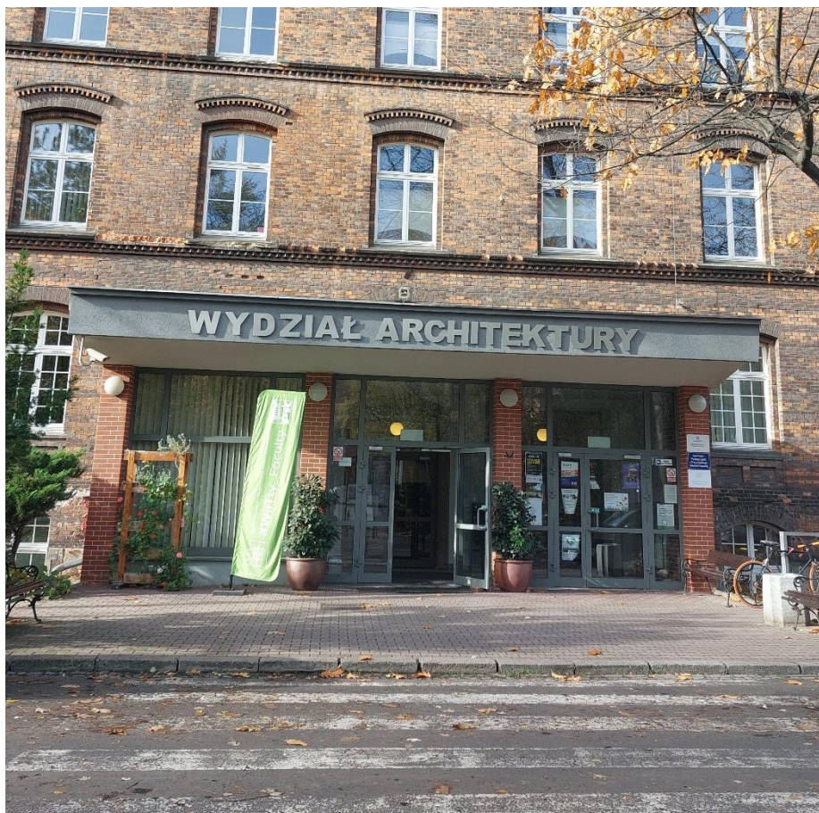
Zdjęcie 19. Główne wejście do WA
