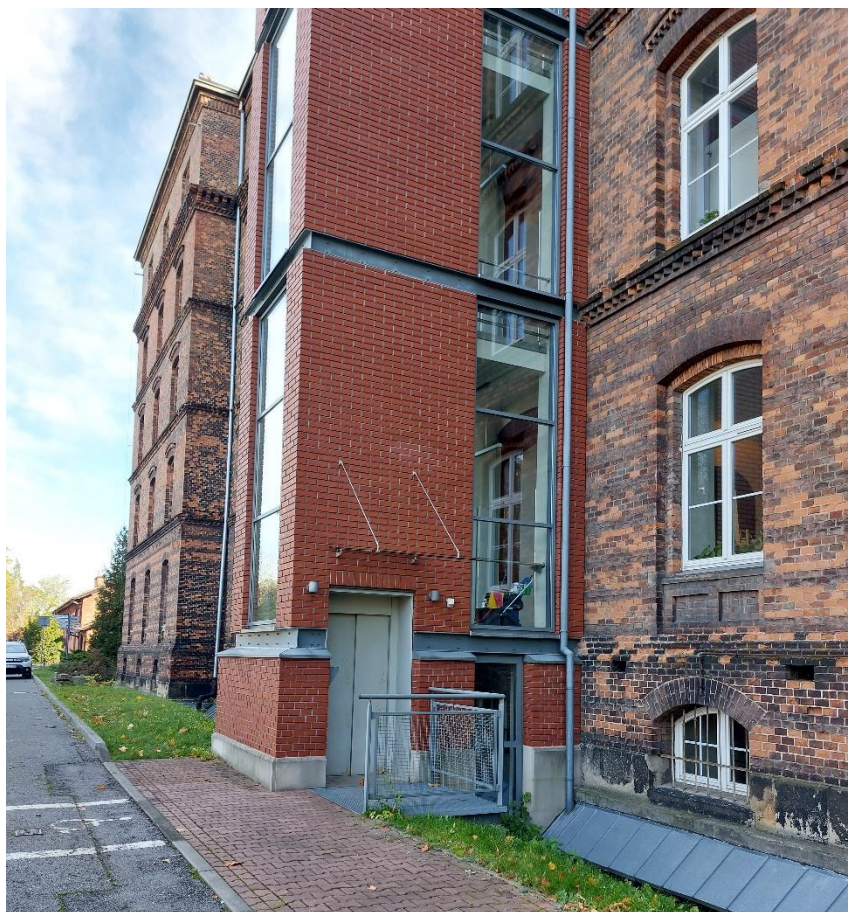
Zdjęcie 20. Winda w budynku WA
