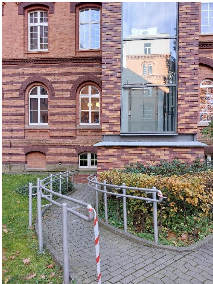
Zdjęcie 2. Podjazd do windy w budynku WIL
