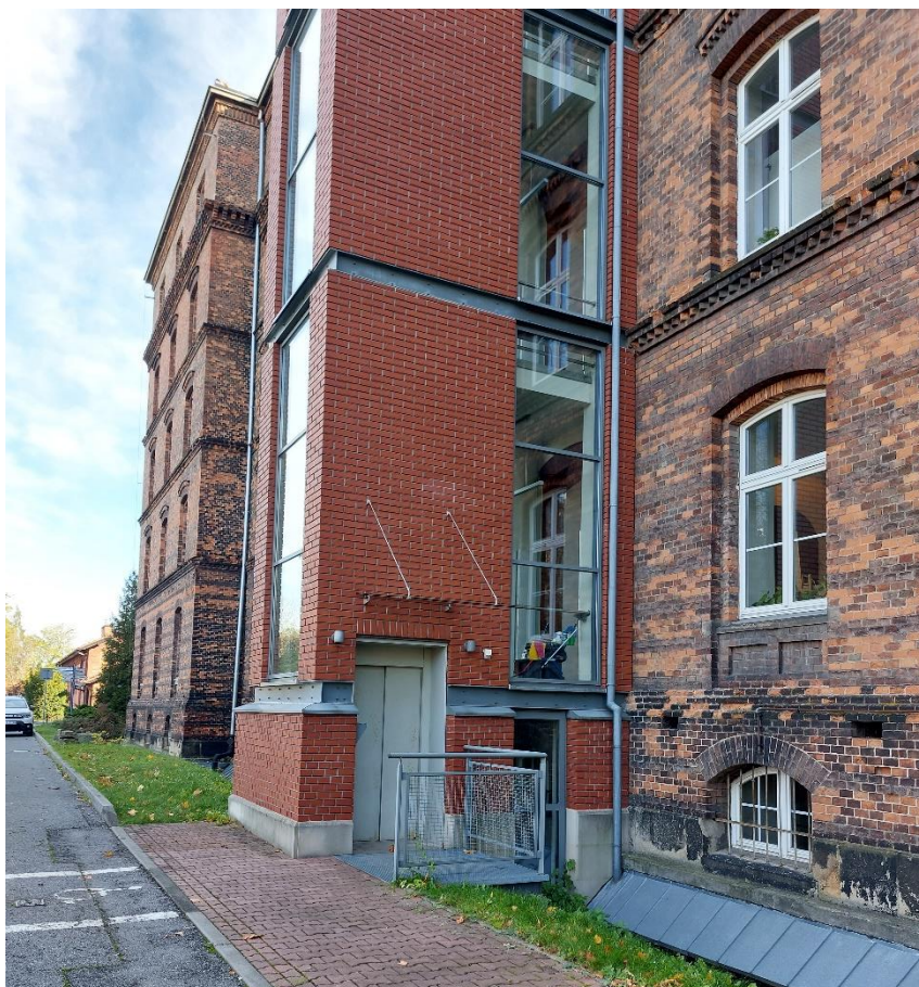
Zdjęcie 9. Winda w budynku WA
